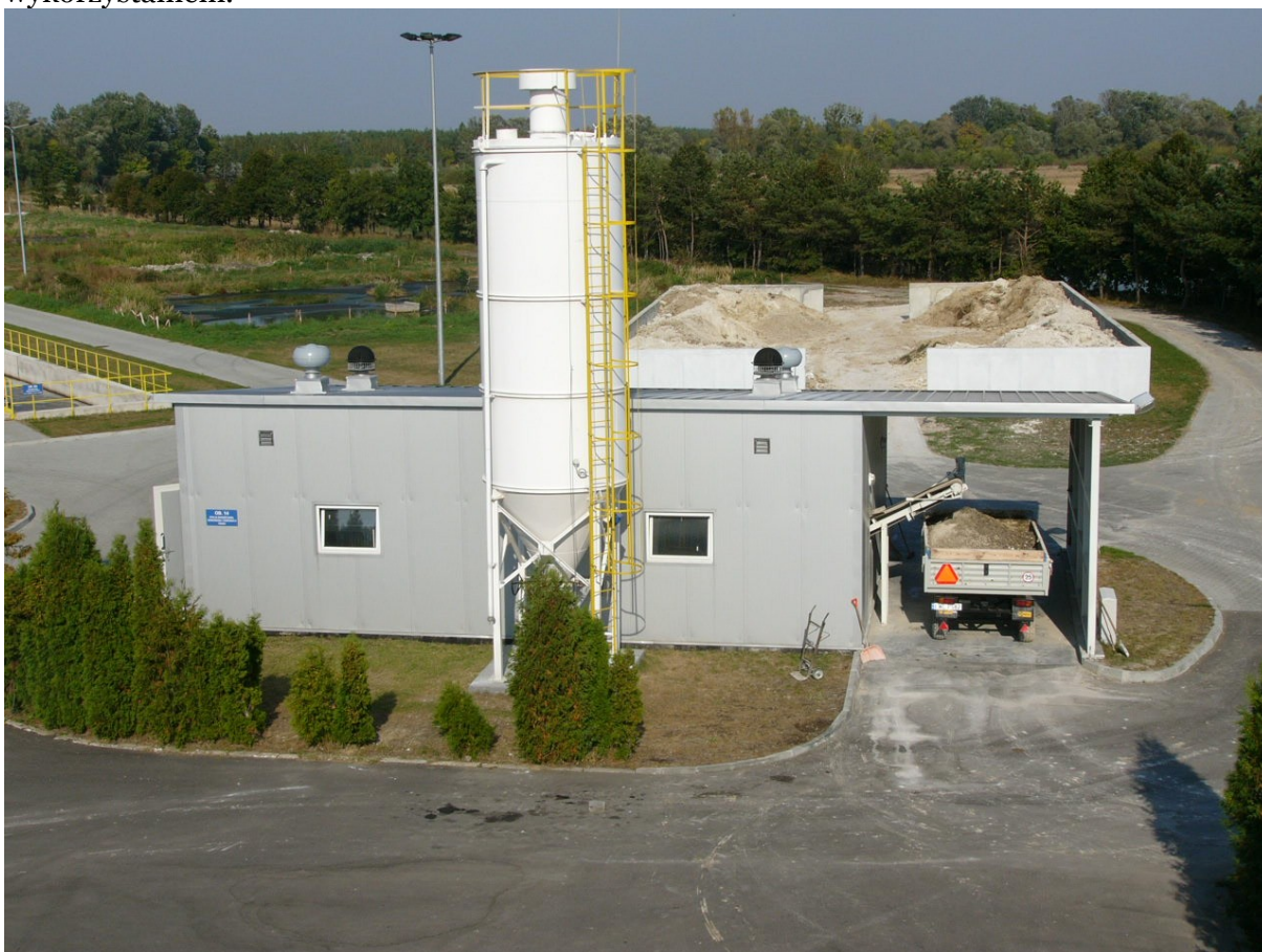
Widok na silos i składowisko osadu po procesie odwadniania i higienizacji
