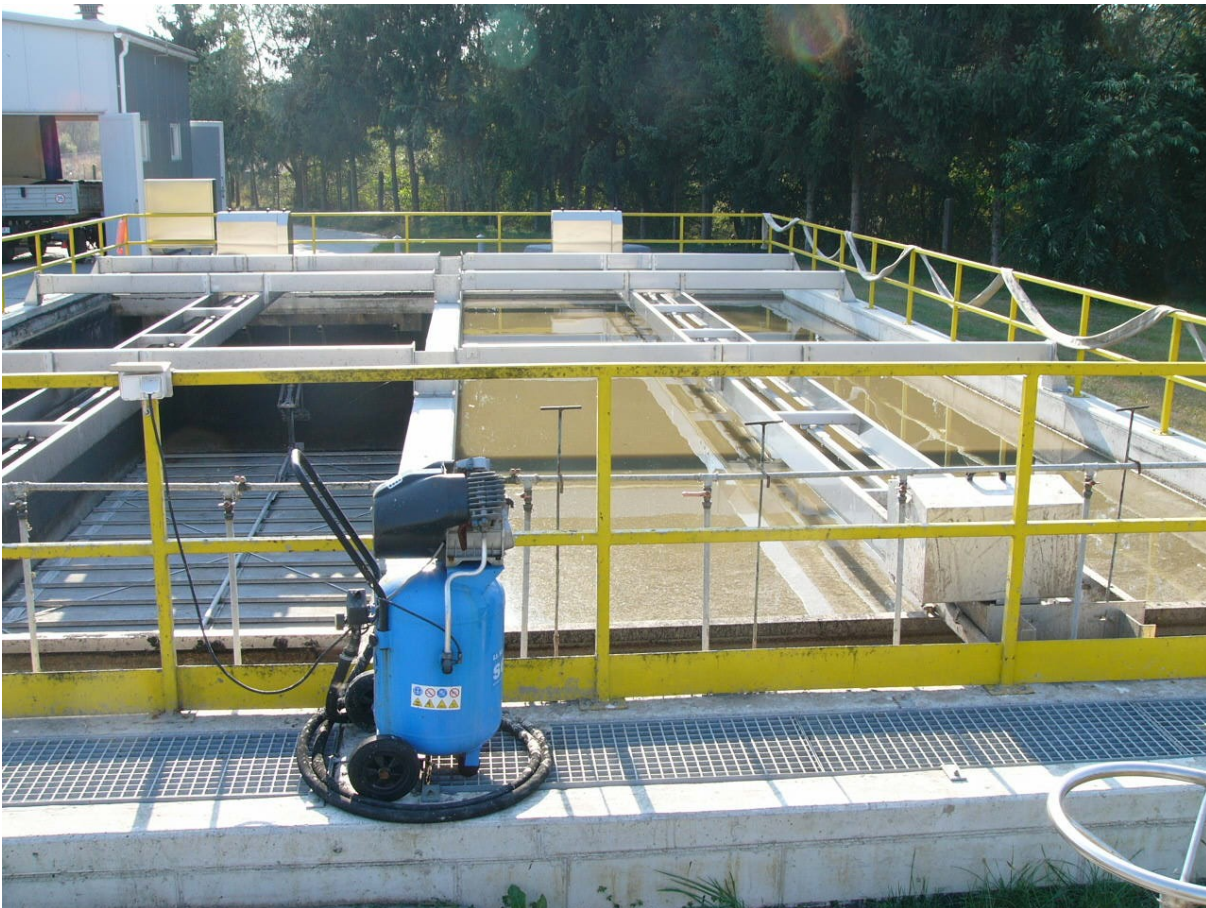
Widok na komory osadników. prawy pracujący, w lewym widoczny zgarniacz denny
