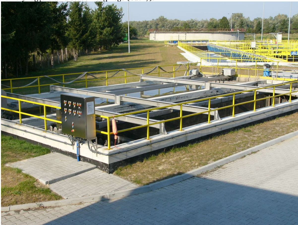
Widok ogólny na osadniki wstępne
